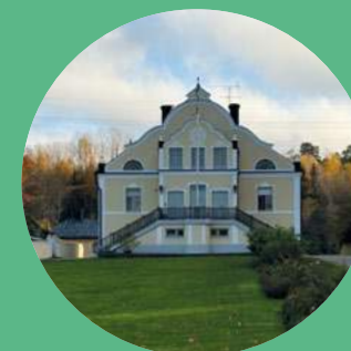
Fasadrenoveringen av Trädgårdsmästarebostaden blev färdig lagom till midsommar. Foto: Linn Bäckman
