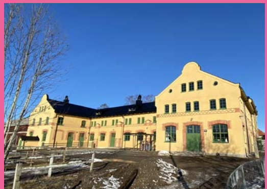
Stora stallet i Hågelbyparken är färdigrenoverat.
